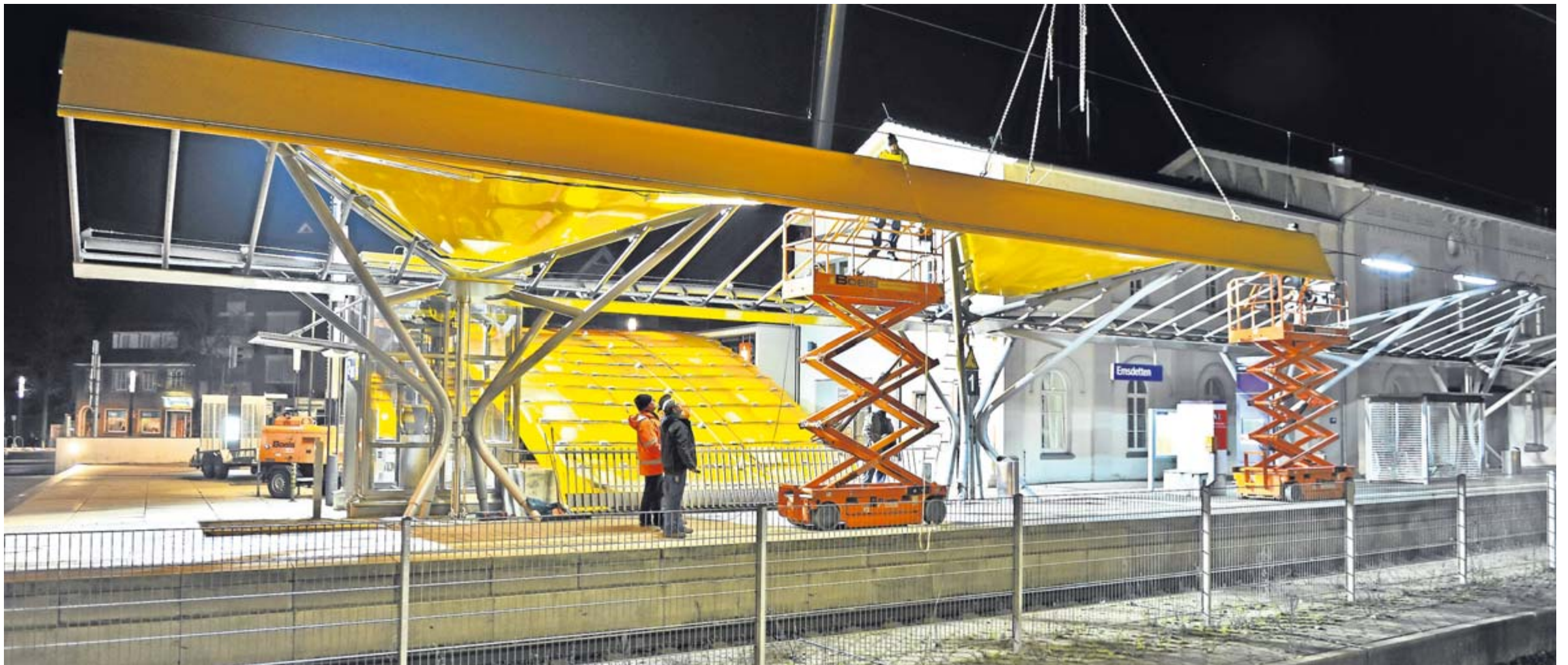
Die Dächer, auf die ganz Emsdetten seit Jahren sehnsüchtig wartet, werden ab ein Uhr in der Nacht auf die Stahlkonstruktionen geschraubt.
